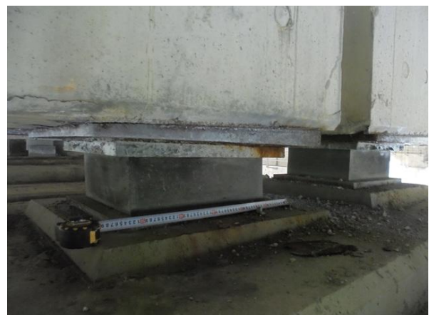
교량받침 이동량 측정
